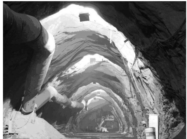
Figura 2: Forma do teto do túnel resultante das altas tensões horizontais.
