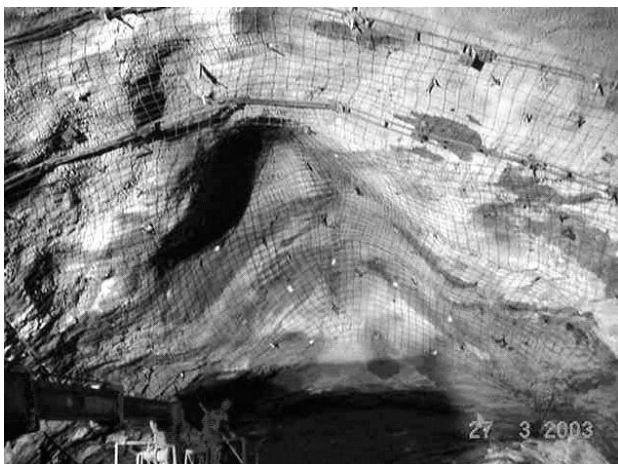
Figura 3: Tratamentos de reforço do suporte do túnel, notando-se a "capela" devida a "rock burst".
