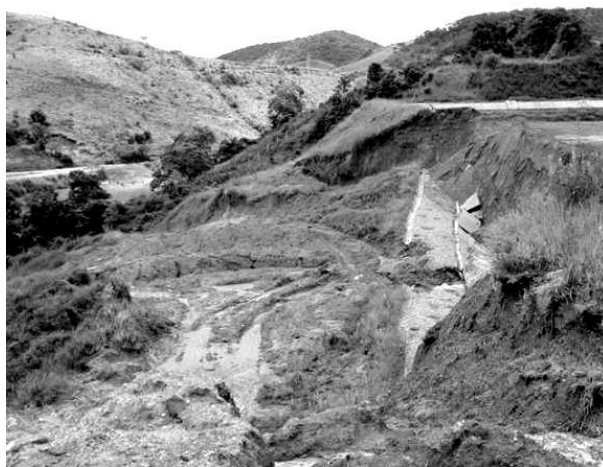
Figura 4: Ruptura da encosta, atingindo o dique de contenção
