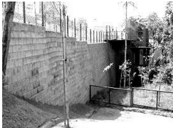
Figura 6: Aspecto do muro de blocos do aterro reforçado
