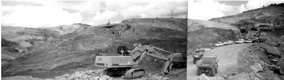
Figura 19: Vista da superfície de ruptura após sua limpeza
