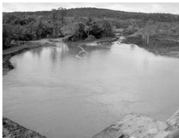
Figura 3: Inundação da Casa de Força
