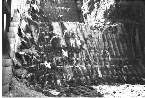
Figura 10: Detalhe da superfície de ruptura
