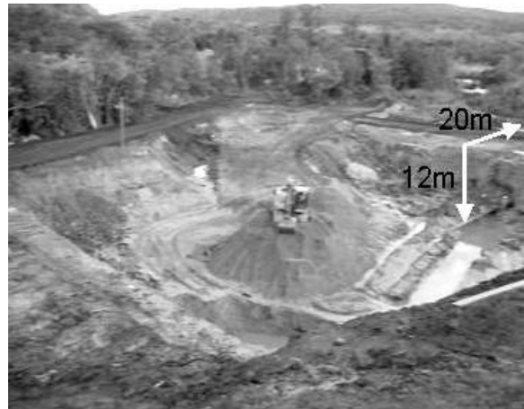
Figura 1: Vista da escavação da Casa de Força.
