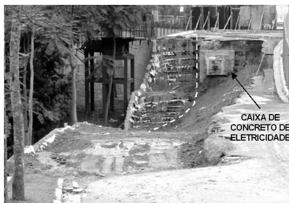
Figura 9: Trecho escavado, vendo-se o muro de blocos, as camadas de geossintético e a caixa de concreto
