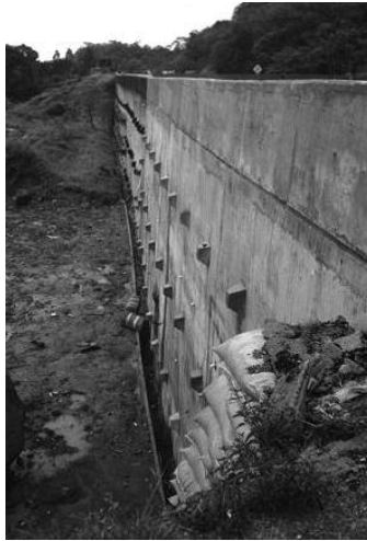
Figura 12: Cortina atirantada existente
